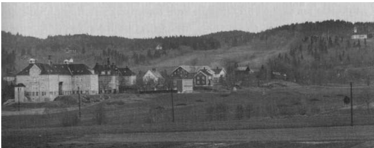
Figur 9: Blakstad sykehus i 1935. Sentralbygningen fra 1924 sees nærmest i bildet. Foto fra boken «Et steg videre» (Mamen, 1999).
