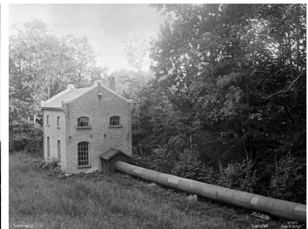
Kraftverk ved Blakstadelva, Blakstad sykehus 1904
