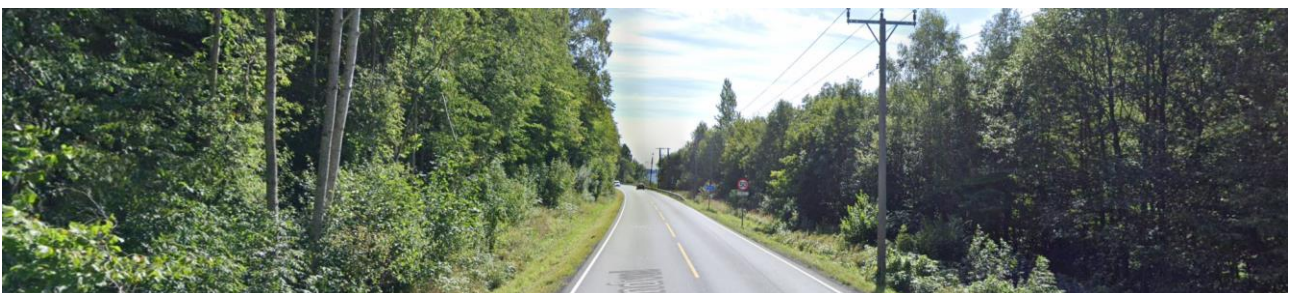
Figur 5: Fylkesveien rett ved krysset. Påkjørselsfarlige objekter innenfor sikkerhetssonen, som høyspentmast, skilt og feil avslutning av rekkverk. (Google Maps, august 2022)
