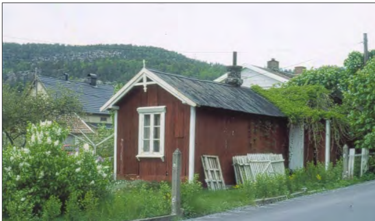
Et godt bevart uthus/bryggerhus fra begynnelsen av 1900-tallet tilhørende Ramsvikveien 6. Uthuset/bryggerhuset er typisk for området med større bolighus i store hager. Foto: Turid Kolstadløkken, Buskerud fylkeskommune
