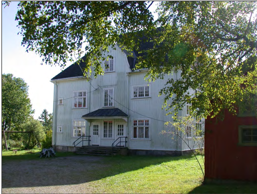
Nedlagte Sundby skole byr på velformet arkitektur i nybarokk stil fra 1922. Foto: NIKU.
