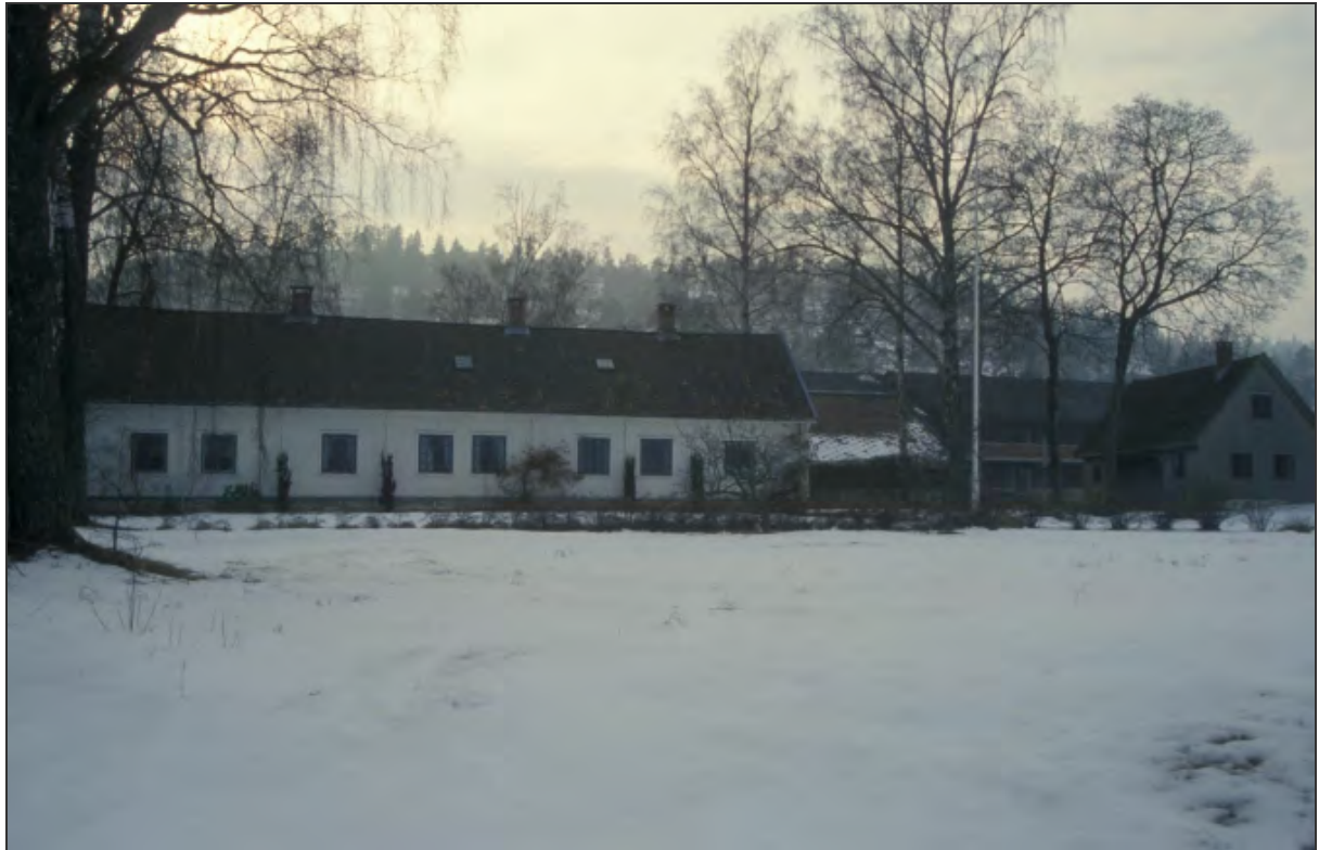
Sætergårdens lave og langstrakte sidebygning er den gamle hovedbygningen på gården. Den er oppført på 1700-tallet og er således blant den riktig gamle bebyggelsen i Hurum. Foto: Jørn Jensen, Buskerud fylkeskommune 1993.
