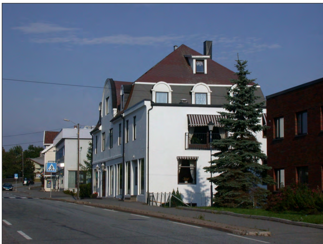
Central gjestgiveri, Vestre Strandvei 1, fra 1928 er en av bygningene med markant arkitektonisk karakter. Den er typisk for nybarokken med sitt høye, knekkete tak (mansardtak) og halvsirkelformete gavlbekroninger. Foto: NIKU.
