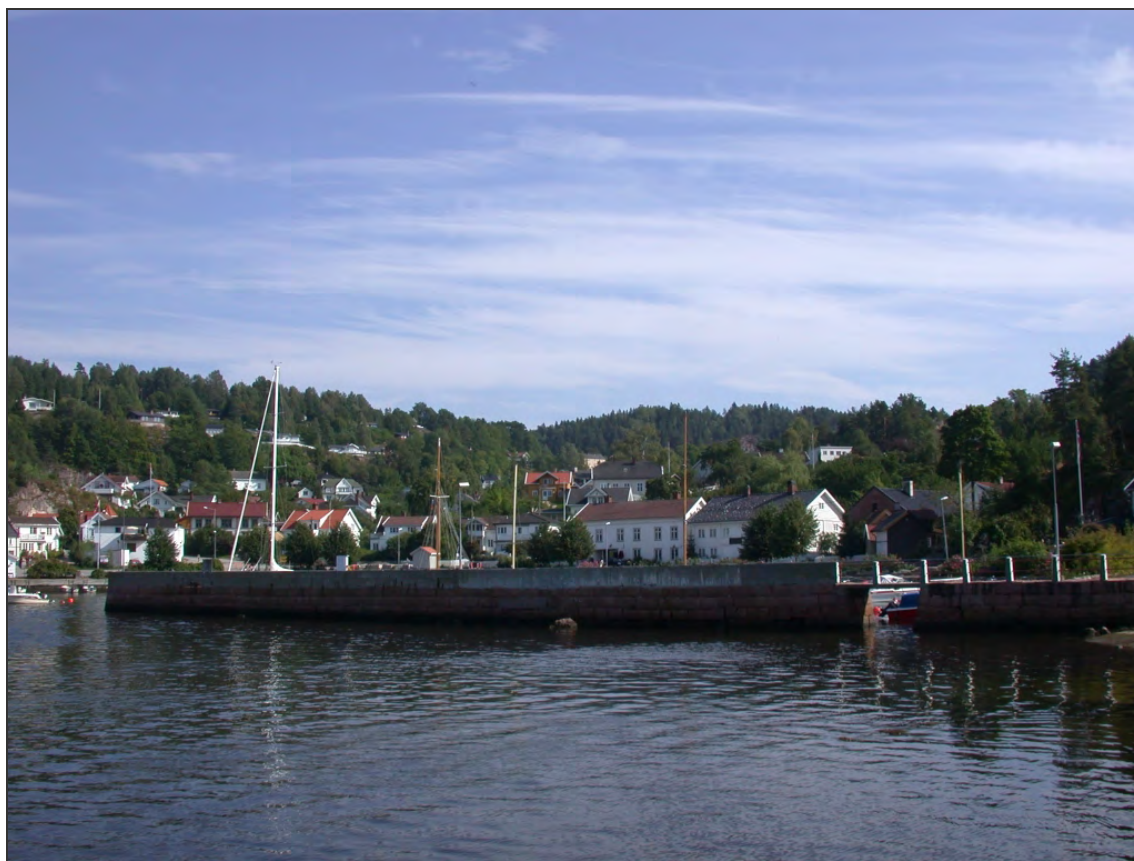
Havnen er etter hvert utbedret med både bryggeanlegg og med moloen som ble anlagt 1930-35. Langs strandpromenaden ser man sentrale, større bygninger for stedets gamle handels- og gjestgivervirksomhet. Foto: NIKU.
