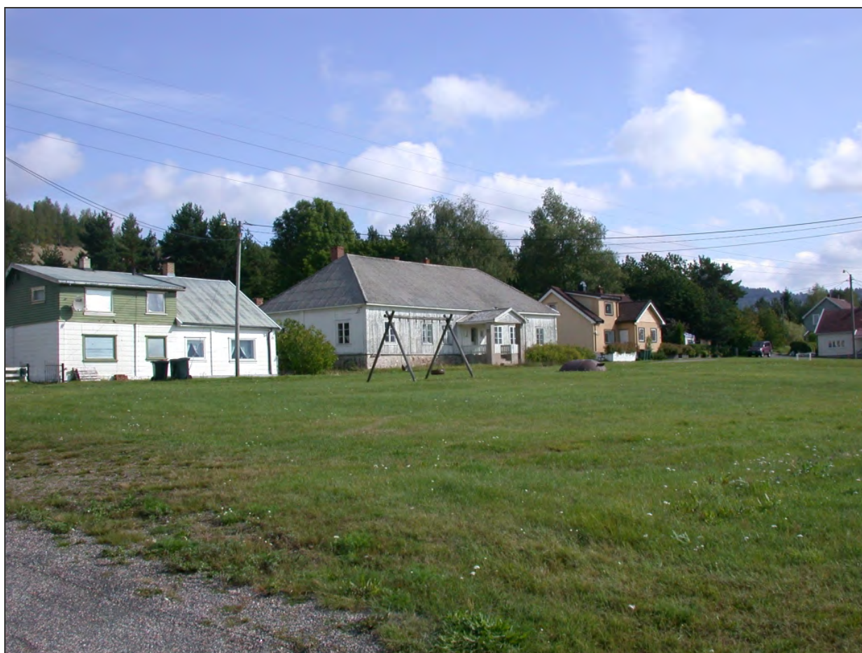
På Bakkeløkka er det forvalterboligen som i størst grad har beholdt sin opprinnelige utforming. Arbeiderboligene som er vertikalt delte tomannsboliger, er derimot sterkt ombygget ut i fra den enkelte eiers individuelle ønsker. Foto: NIKU.
