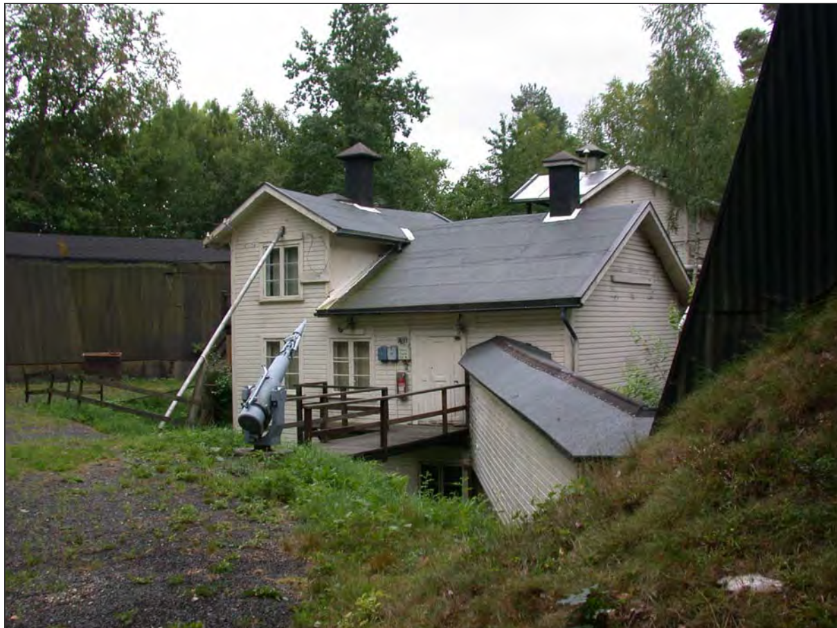
Fabrikkbygning fra det eldste bevart anlegget fra 1896 som ble oppført etter en større eksplosjon. Anlegget inngår i Engene Sprengstoffhistoriske industrimuseum. Foto: NIKU.
