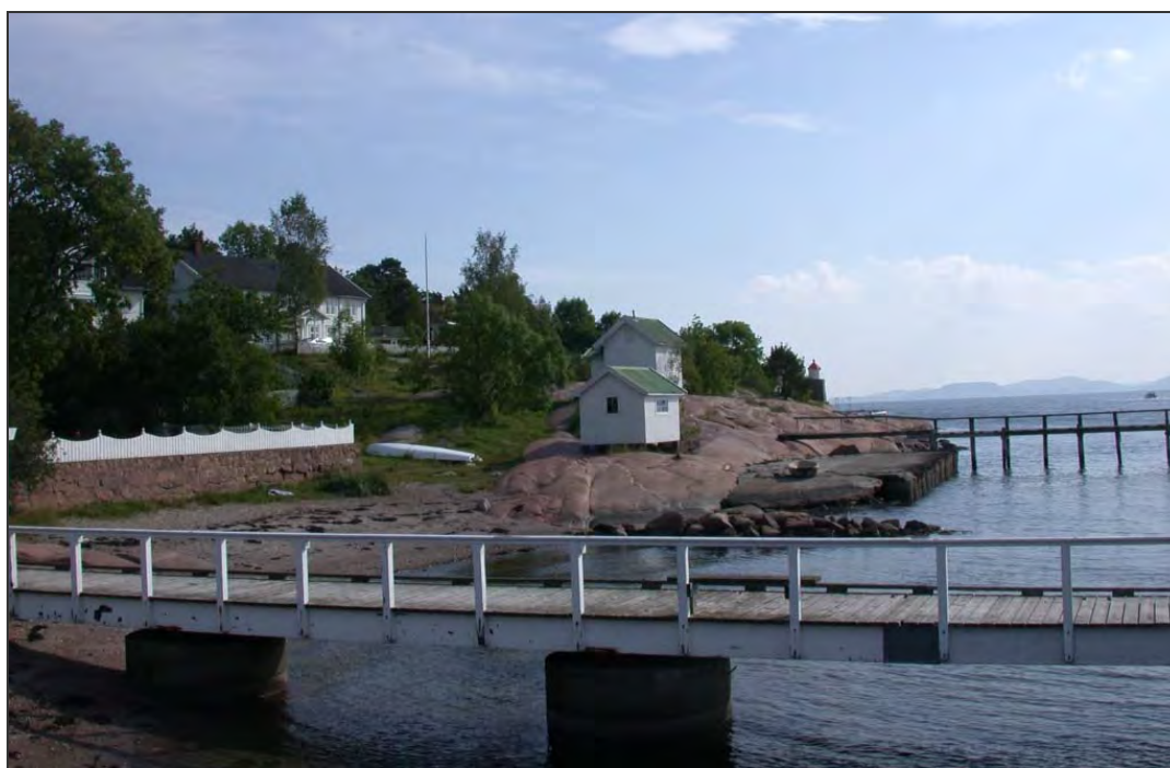
Rødtangen sett mot syd fra Dampskipsbrygga. På knausene står en liten lagerbu og en utkikksbu for losene. I bakgrunnen skimtes tollstasjonens store empirehus. Foto: NIKU.
