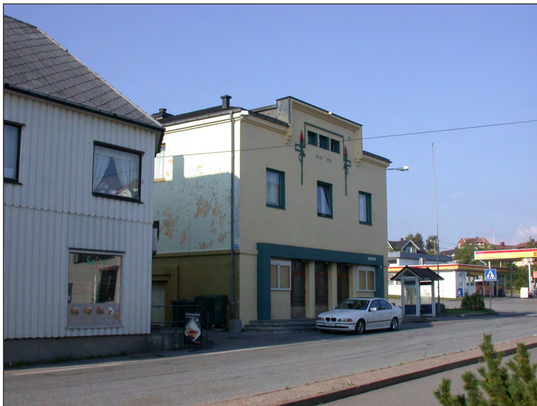
Folkets hus, Vestre Strandvei 2 er oppført som forsamlingshus og kino i 1930. Fasaden har dekorasjonselementer fra art deco-stilen som er sjelden i Norge. Foto: NIKU.
