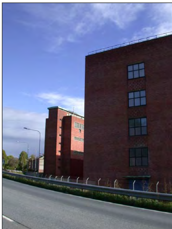
De to bygningene lengst nord på Tofte cellulosefabrikk sett fra Østre Strandvei. Foto: NIKU.
