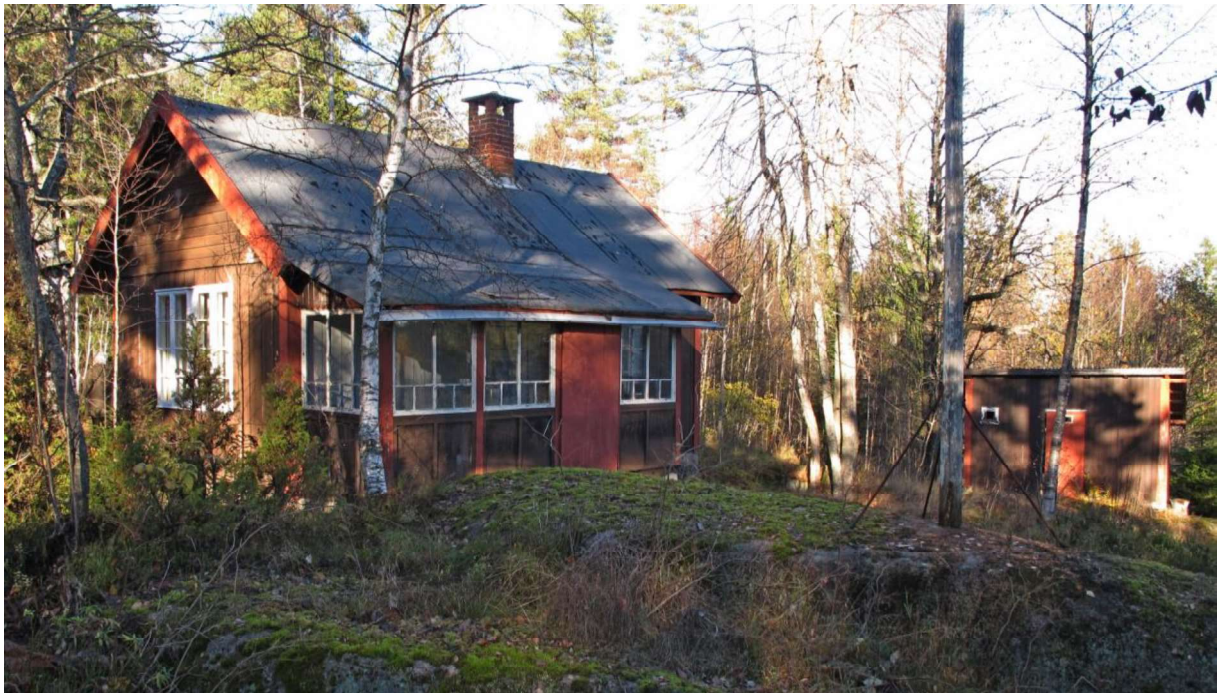
Bekkevoll er en av mange små hytteeiendommer i Hallenskog, skilt ut i 1925. Anlegget er lite endret og et fint eksempel på de små skogshyttene.
