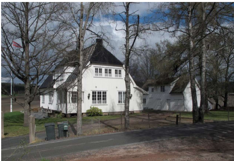
Doktorboligen på Klokkergårdshøgda er typisk for trenden først på 1900-tallet som søkte forbilder i byggeskikken før sveitserstilperioden. Anlegget skal være bygd rundt 1910 som bolig med legekantor. I sidebygningen var det bryggerhus, tjenerbolig og vognskjul
