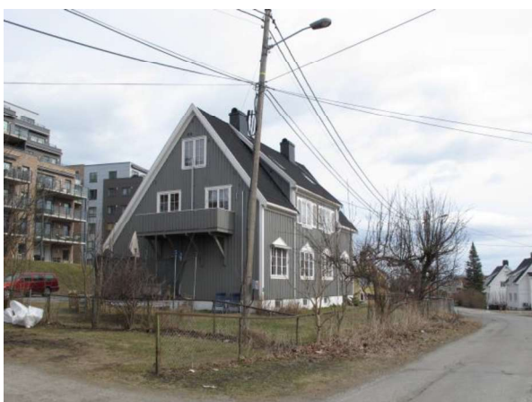
Arbeiderboligen i Boligveien 11 på Slemmestad er ført tilbake til opprinnelig stilpreg. Anlegget, som går under navnet «Brunegårda», ble bygd ut mellom 1916–1920 med sementfabrikken som byggherre.
