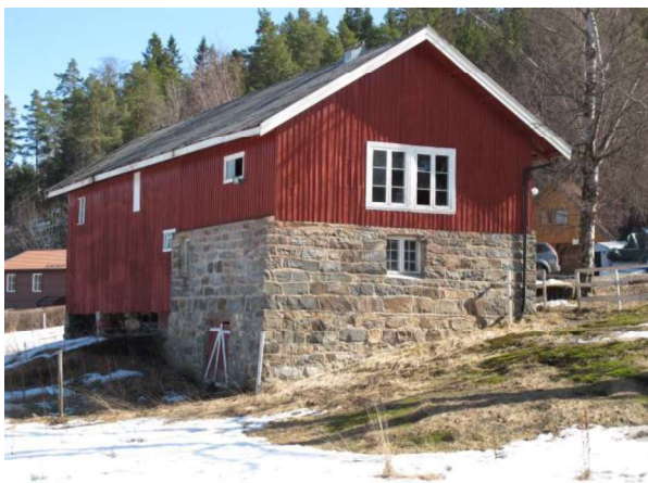
Liten driftsbygning på arbeiderbruket Solstad i Bødalen, med fjøs/stall i fin gråsteinsmur. Selv om det er mange høye og fine gråsteinskjellere fra slutten av 1800-tallet, er gråstein som veggkonstruksjon sjelden.
