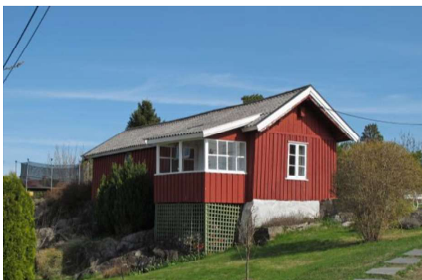
Dette var opprinnelig bryggerhus, do og grisehus på boligeiendommen Kjærnes på Nærnes. Veranda-utbygget røper ny funksjon som sommerbolig. De fleste bryggerhusene på Nærnes har tilsvarende verandaer.
