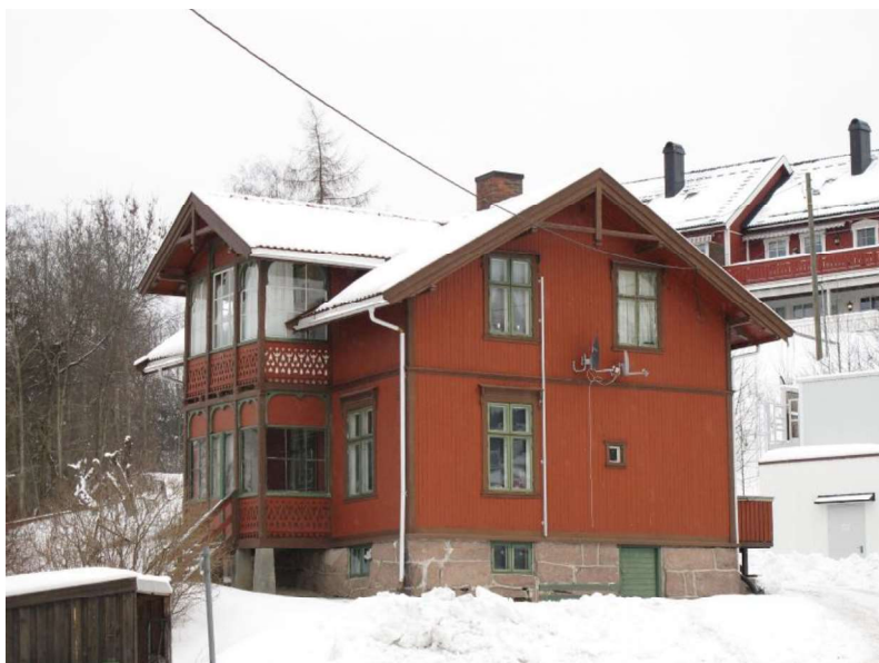
Bolighus i Jaklandsveien i Røyken sentrum, trolig bygd rundt 1910. Huset er typisk for sveitserstilhus i tettsettsbebyggelsen og basert på tilnærmet firedelt grunnplan. Huset er et av de mest opprinnelige i Røyken. Det er kjent som den tidligere telegrafstasjonen.
