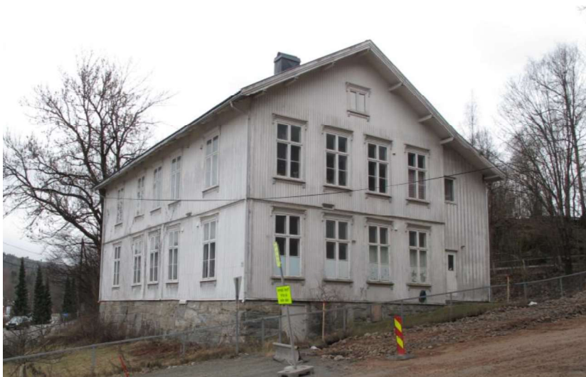
Som svar på befolkningsveksten på industristedet, ble Slemmestad egen skolekrets i 1896. Først holdt skolen til i leide hus, men fikk egen ny skolebygning i 1899. Den var på én etasje og ble straks for liten. Andre etasje på påbygd 1910.
