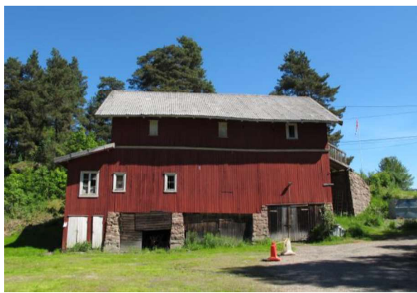
Driftsbygningen på Skogsborg.
