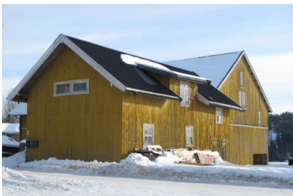
Driftsbygning og vognskjul på Vang bruk 3.
