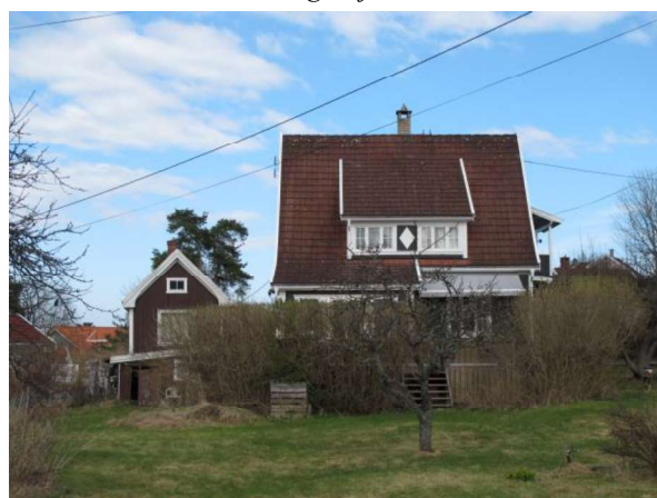
Boligeiendommen i Saltbutangen 3 på NærSENS ble skilt ut i 1925 og trolig bebygd da. Hovedhus og uthus har samme stilpreg. Stilpreget er i registreringen ført som «Byggmesterjugend», som kan brukes som en samlebetegnelse for flere trender i perioden.
