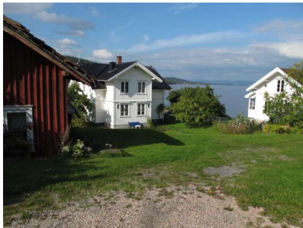
Østre Løkkeberg til venstre, med nytt vinkelutbygg mot tunet. Bolighuset på Skjervik til høyre.
